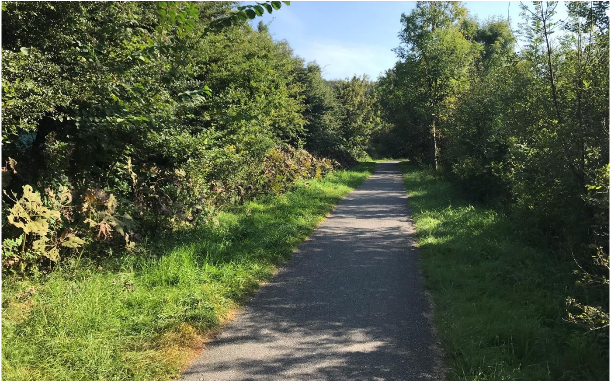
Abbildung 14: Ausgebauter Fahrrad- und Wanderweg zwischen LRT Nr. 3150 und Planungsraum.
