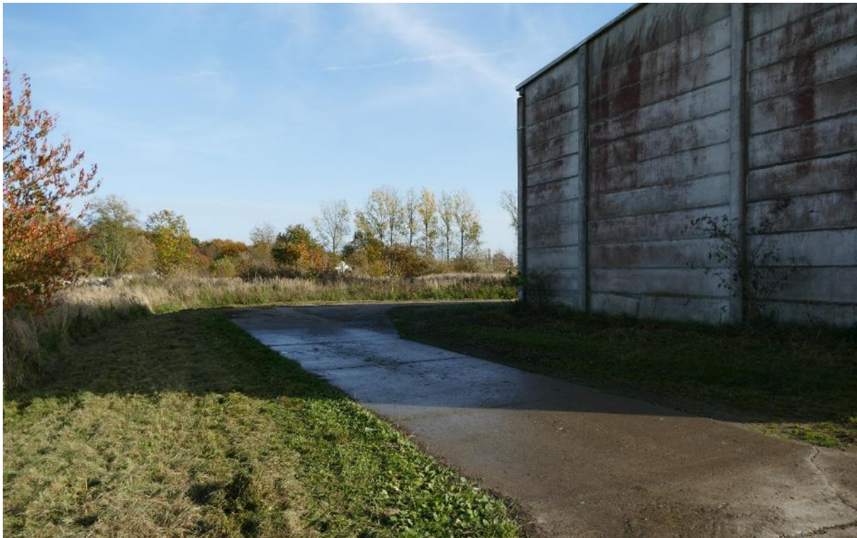
Bild 02 Blick Richtung SO, Lagerhalle westlich des Vorhabens, Plangebiet im Hintergrund
