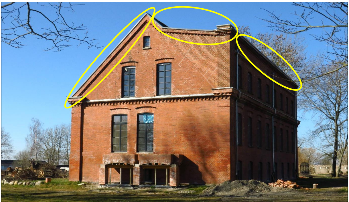
Abb. 6: Quartier Q4. Das Dachkantenblech wurde umlaufend an mehreren Stellen angefliegen (Zwerg- und Mückenfledermäuse), aber letztendlich nur von Einzeltieren - vmtl. als Männchenquartier - genutzt.
