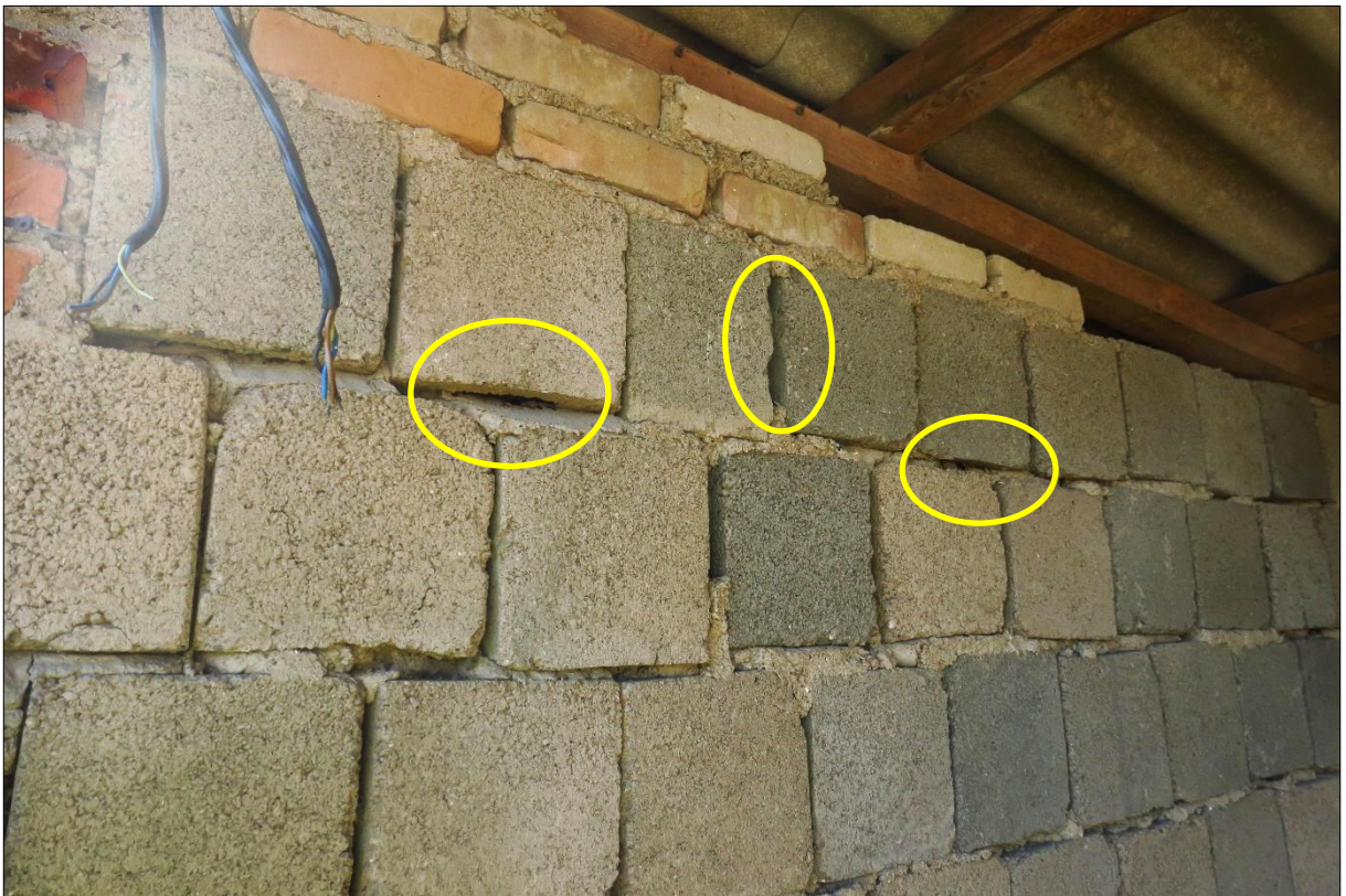
Abb. 3: Quartier Q1 in Hohlblocksteinwand. Drei Einzel-Quartierbereiche konnten 2022 erfasst werden.
