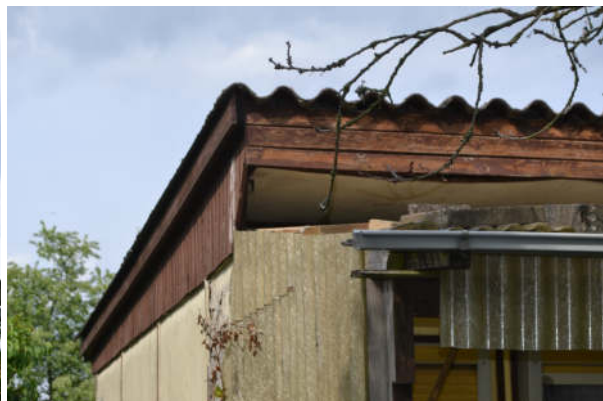
Bild 46: Dach Vorbau (Nr. 14, Garten Nr. 27)
