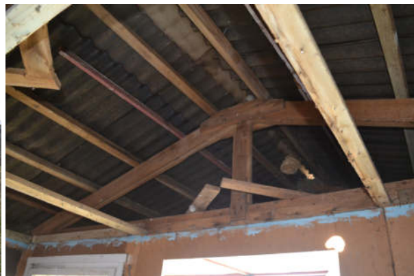
Bild 38: Dachkonstruktion der Laube (Quartier)
