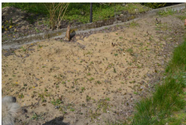
Bild 31: Kiesfläche nach Entwendung von Platten
