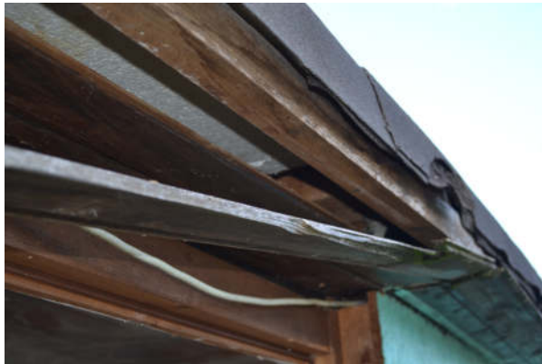
Bild 41: Dachbereich außen... (Laube Nr. 3)
