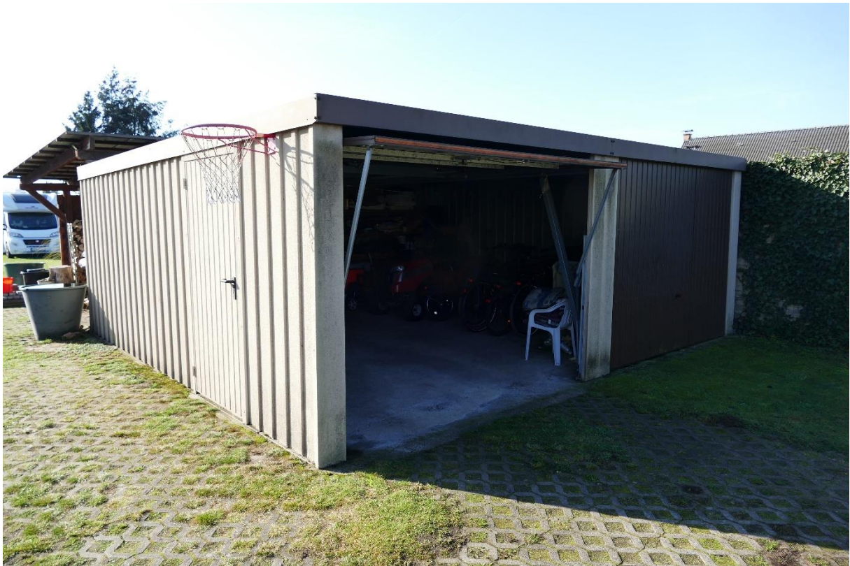
Bild 23 massiver Schuppen mit Blech verkleidet, ohne QP
