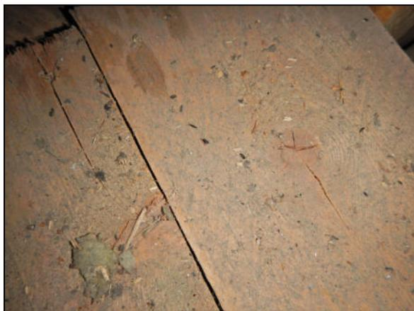
Abb. 9: Spuren von Fledermauskot auf dem Dachboden der Aldi-Marktfiliale
