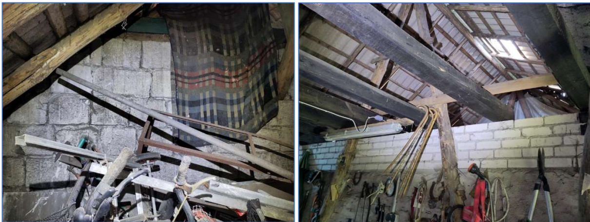
Abb. 10 und 11 Bereiche in der Scheune mit Mauerwerk
