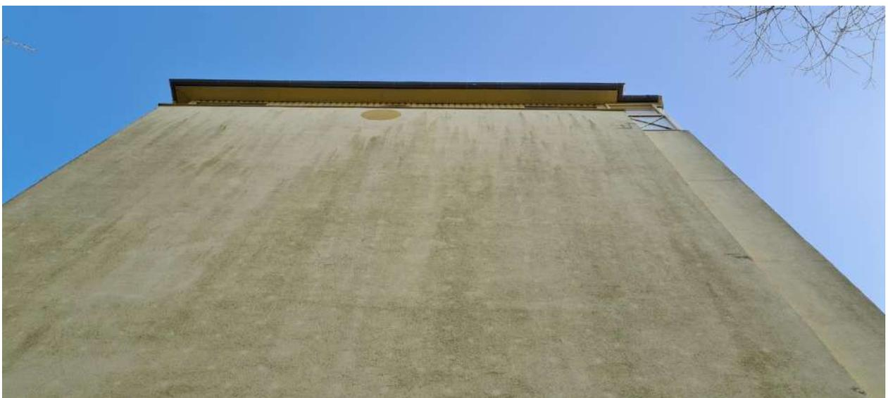
**Abbildung 8: Die Giebelwand des Bestandsgebäudes, die Trapezbleche mit den Lücken sind unterhalb des Dachüberstands gut zu erkennen.**
