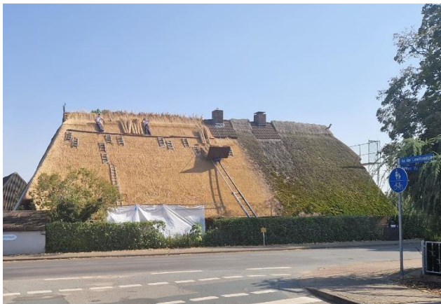
Abb. 10: Sanierung des Reetdaches
