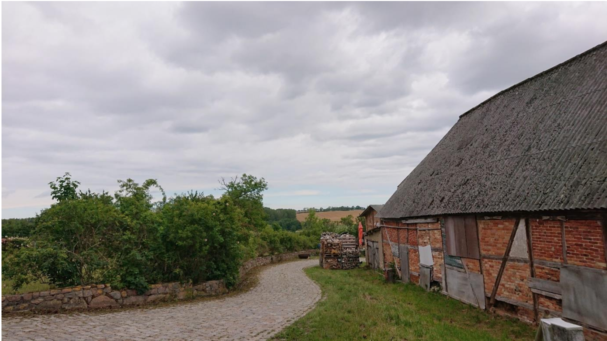
Abbildung 30 Blick von Bobbin Richtung Baldereck, gestörte Sichtbeziehung durch aufgekommene Gehölze
