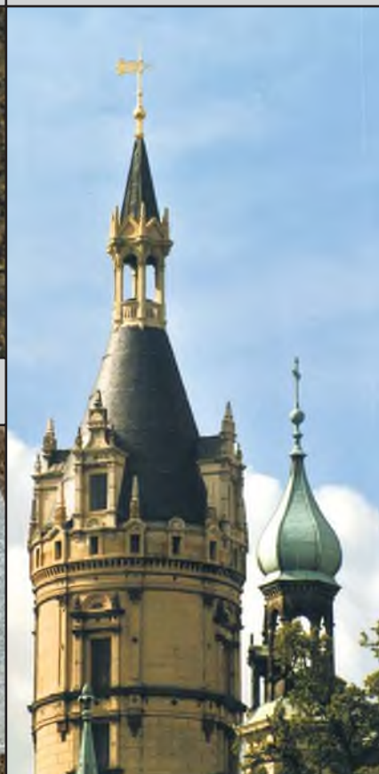
Hochpunkt (Turm Knopf u. a.)
