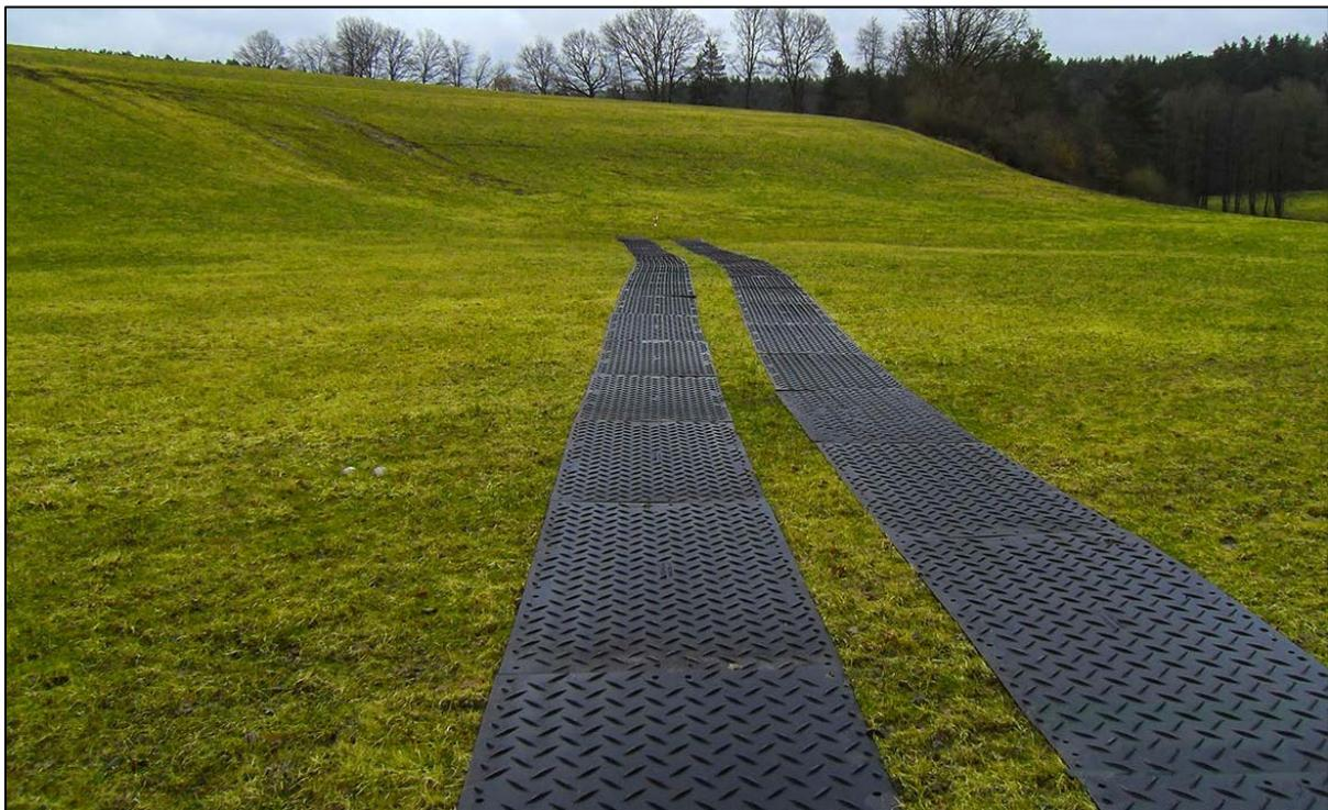
**Abbildung 7:** Beispielfoto mobile Baustrasse zur Vermeidung von Bodenverdichtung (<https://www.securatek.de/Referenzen/s-tek-48-Hochleistungs-Bodenschutzplatte-als-Mobile-Baustrasse-beim-Rohrleitungsbau-bei-Creussen-in-Bayern>)
