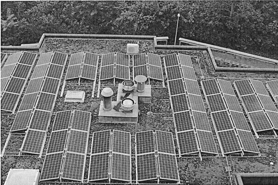
Abb. 12: Aufgeständerte PV-Anlagen auf einem Gründach, Quelle: <https://www.enbw.com/blog/energie-wende/solarenergie/photovoltaik-auf-dem-flachdach-geht-das/>
