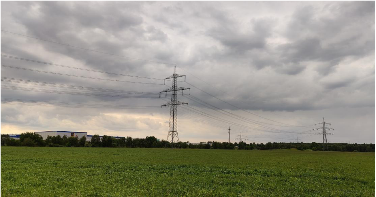
Bild 2.1.4: Foto der PV Fläche (Quelle: SolPEG, Ortsbegehung)
