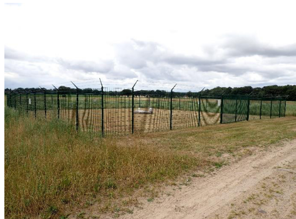
Abbildung 11: Trinkwasserquelle als Sonstige Ver- und Entsorgungsanlage
