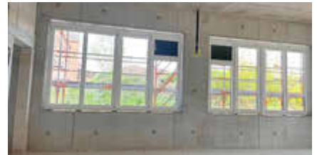
Blick aus einem künftigen Klassenraum in Richtung Hof
