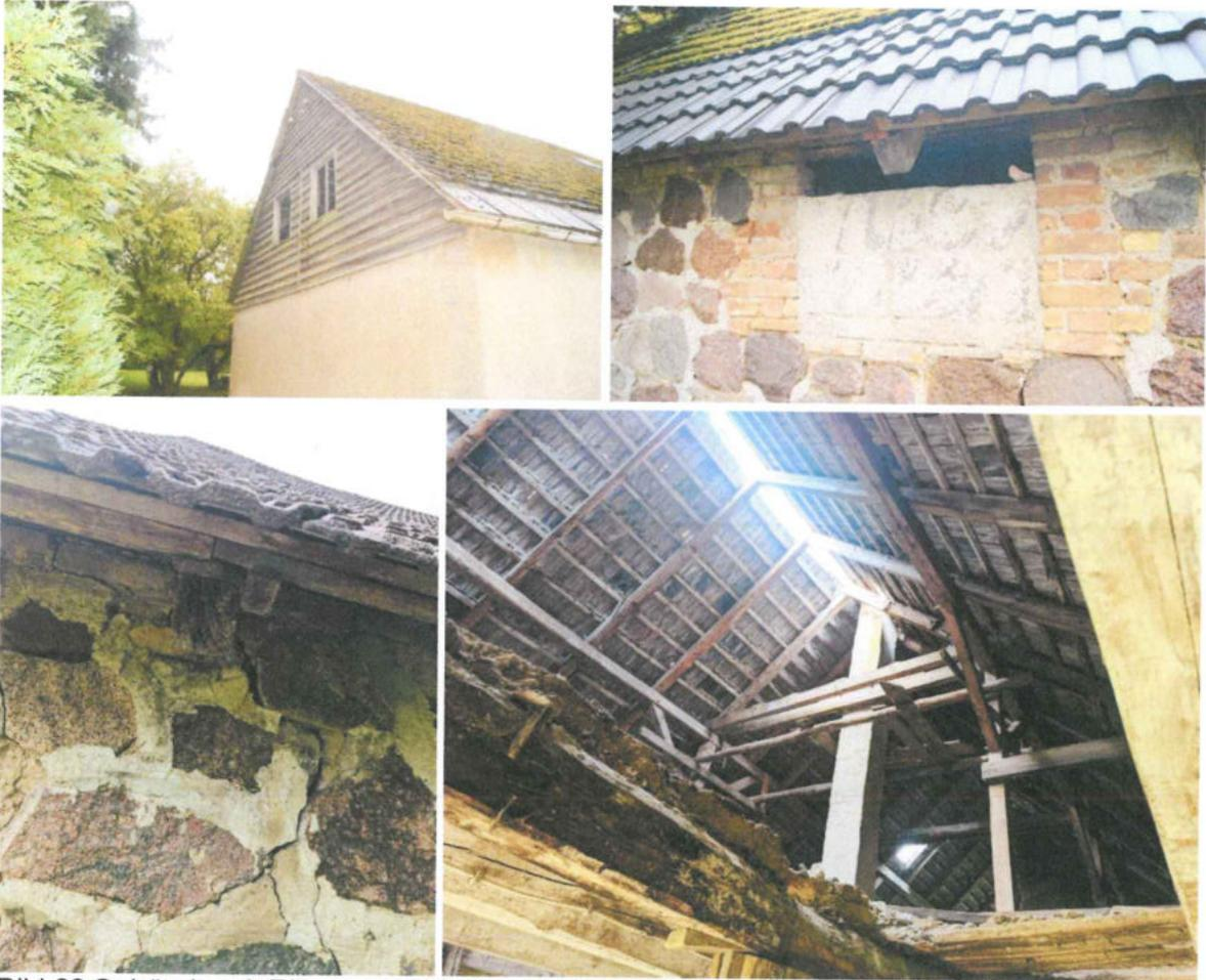
Bild 09 Gebäude mit Rissen und Spalten, Einflugmöglichkeiten ins Gebäudeinnere
