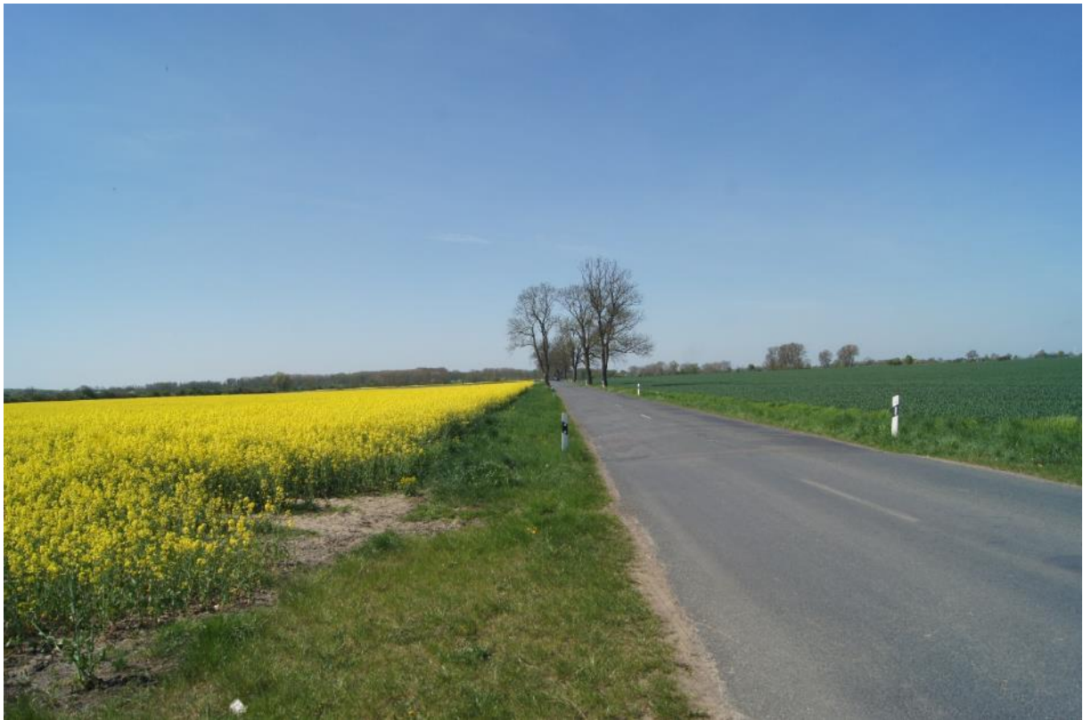
Bild 03 nördlich des UG verlaufende Kreisstraße
