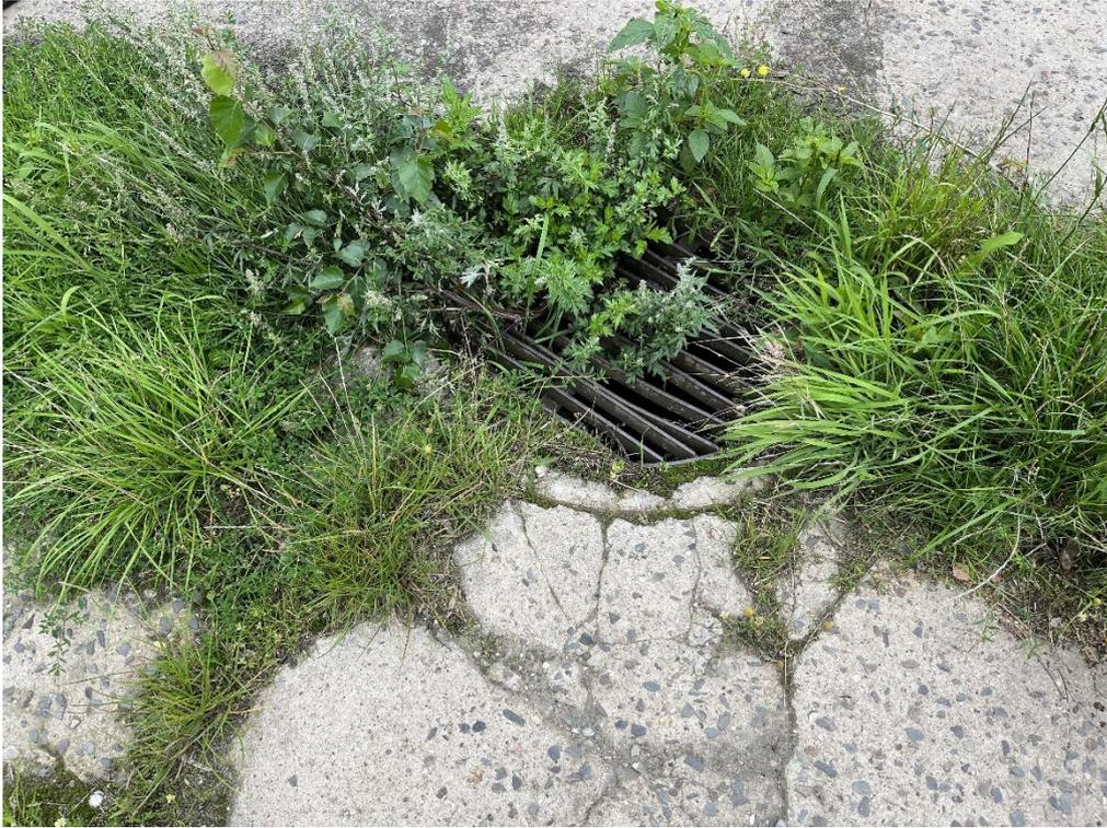
Abbildung 5: Schachtbauwerk mit Einlaufrost
