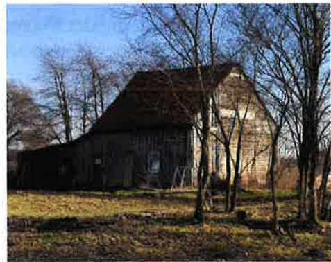
Abbildung 7 Blick von Westen in Richtung Osten auf die Rückseite der Scheune außerhalb des Plangebietes, Foto F.-P. Schulz, 21.02.2021
