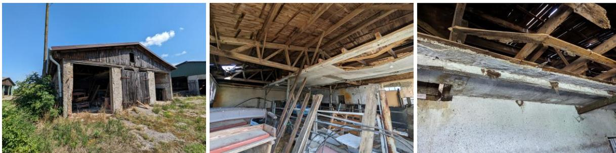
Abbildung 9: Geräteschuppen mit offenem Dachstuhl und fehlenden Toren.
