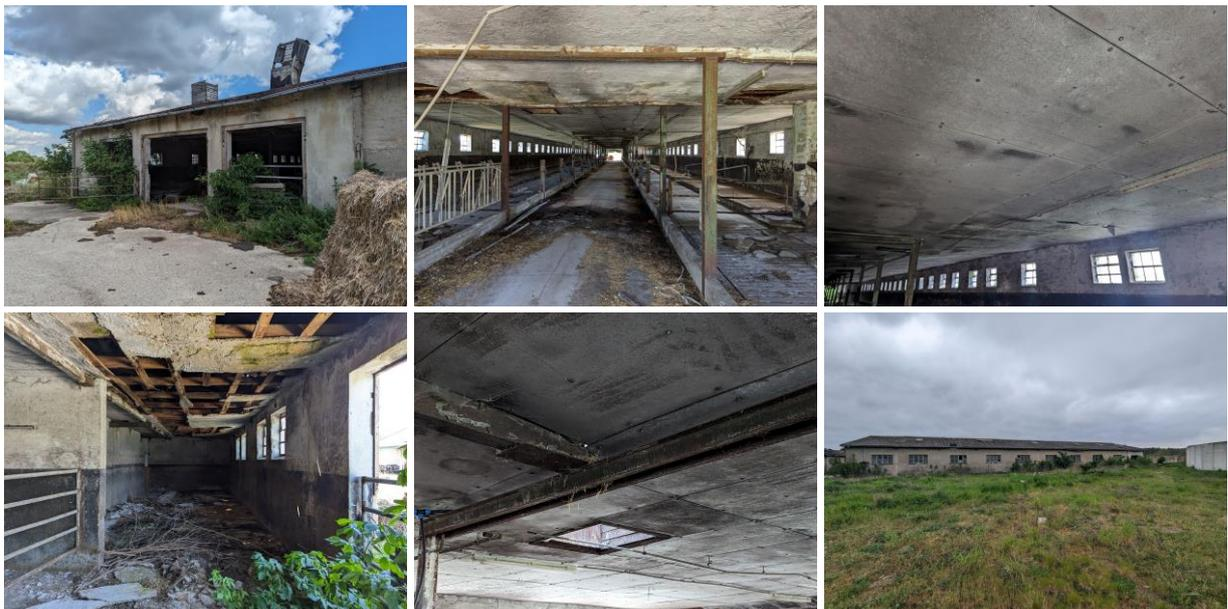
Abbildung 6: Aufgelassene Stallungen mit abgehangenem Dachstuhl.
