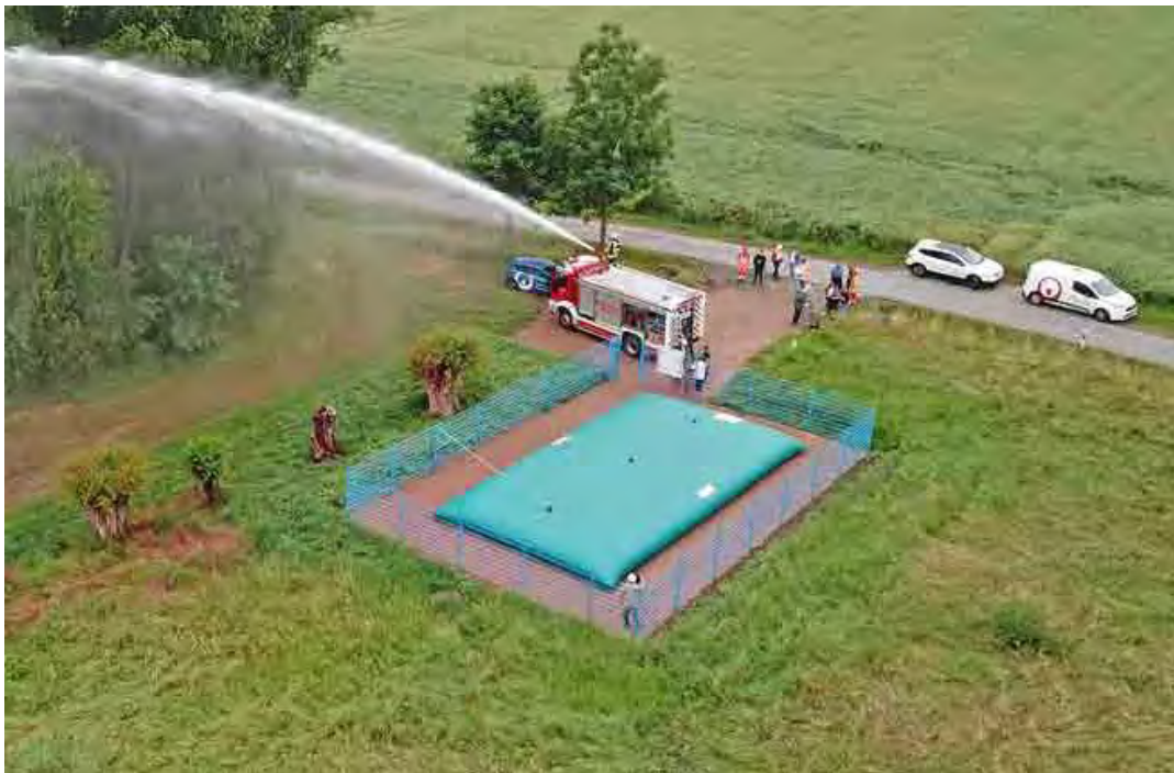
Abb. 7: Beispiel einer baulichen Anlage für die Löschwasserbereitstellung durch eine oberirdische Löschwasserzisterne (Löschwasserkissen) (Quelle: Veolia GmbH, 2022)
