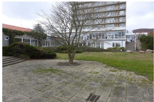
Betonplatten, Zierrasen, Ziergehölze (Abbruch)
