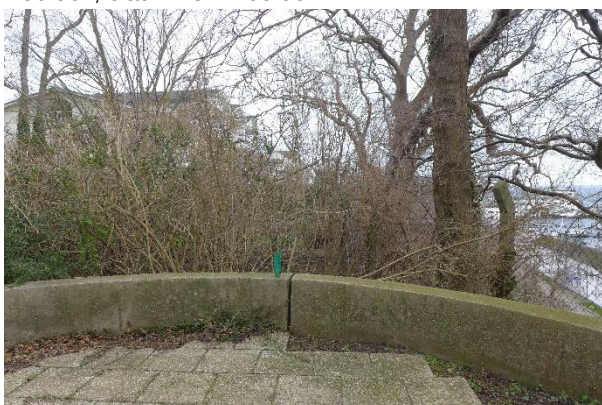
Terrasse im Hangbereich (Abbruch)
