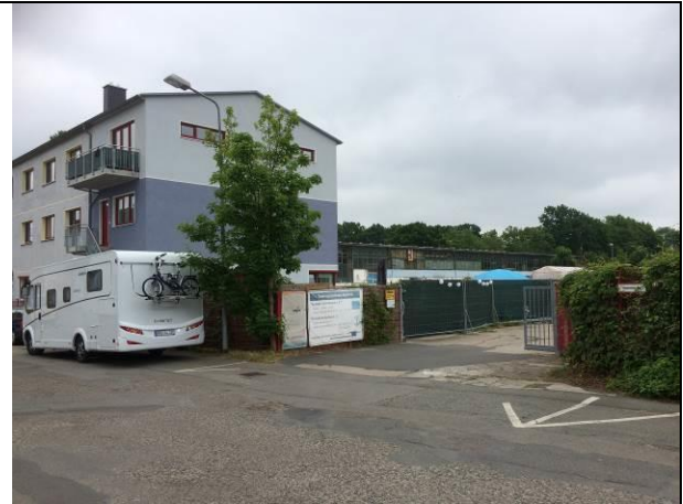
Bestandgebäude mit Büronutzung am Kassebohrer Weg.
