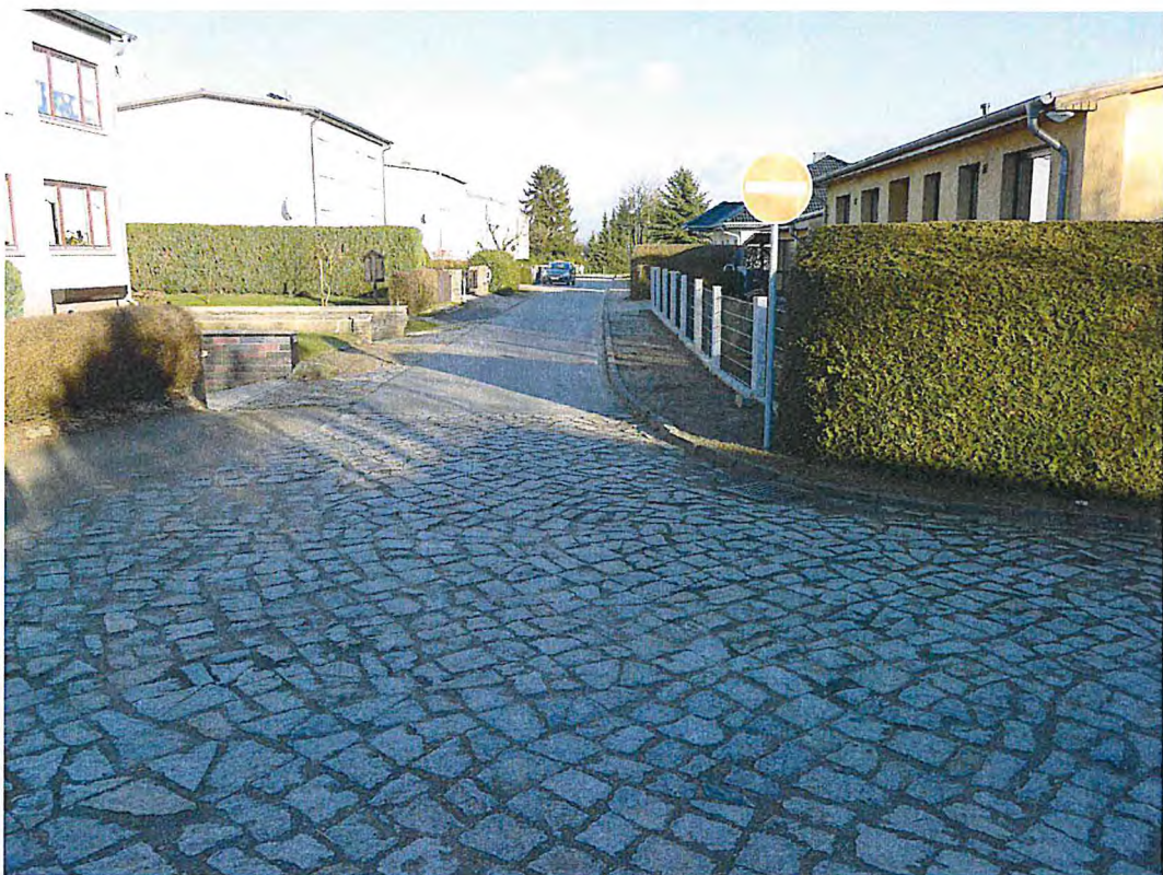
zweigeschossige Bebauung an der „Blumenstraße“
