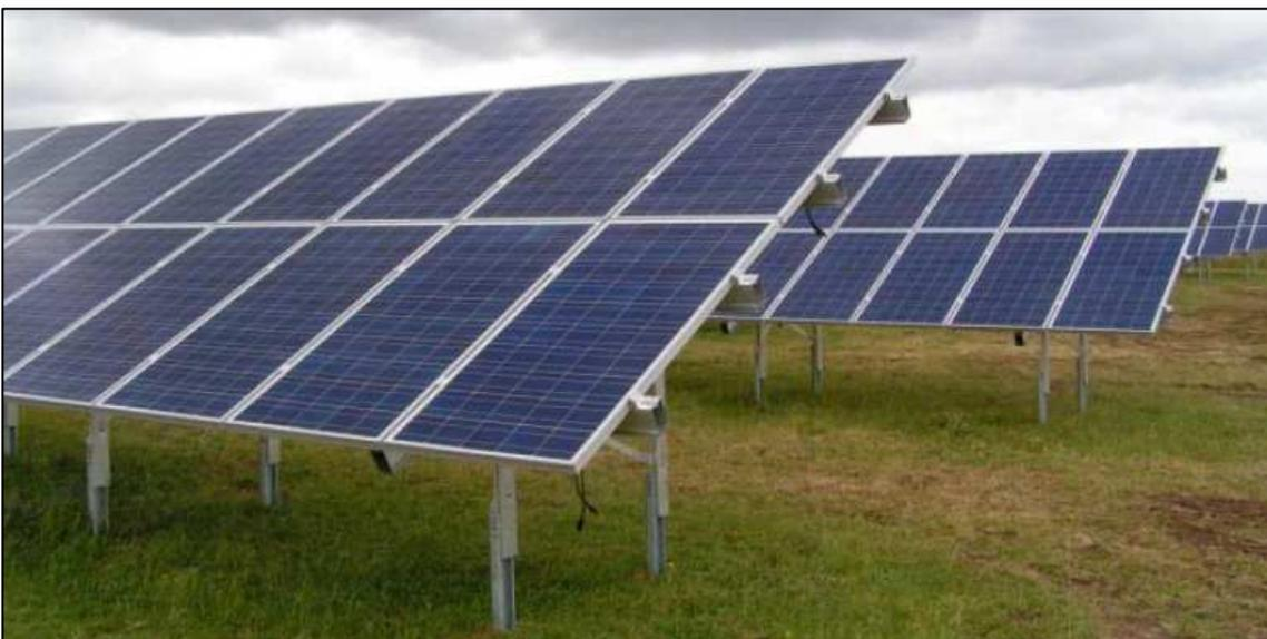
Abbildung 2: Detailansicht von zweireihigen Modultischen. Quelle: S.I.G. 2012.
