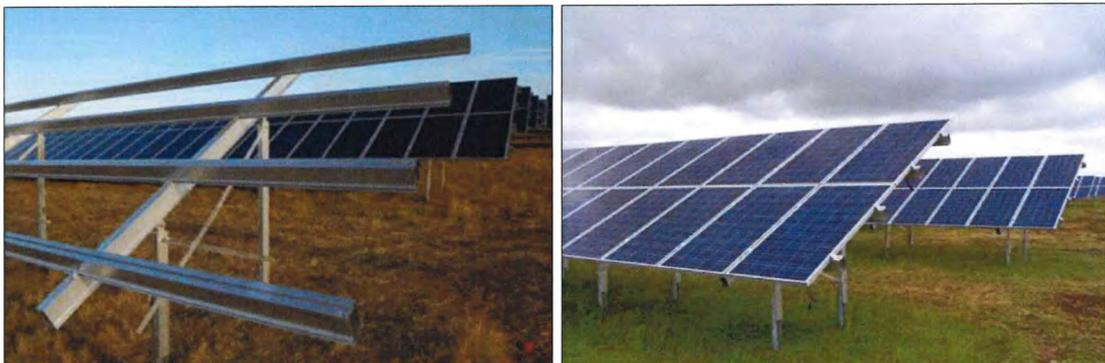
Abbildung 3: Systemdarstellung zur Aufständering der Gestelleinheiten auf gerammten Pfosten und Detailsicht zweireihiger Modultische. Quelle: S.I.G. 2012.
