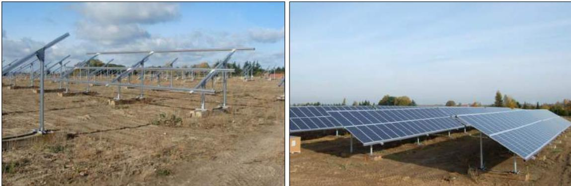
Abbildung 2: Systemdarstellung zur Aufständierung der Gestelleinheiten und Fundamentierungsvariante auf Bahnschwellen. Quelle: S.I.G. 2012.
