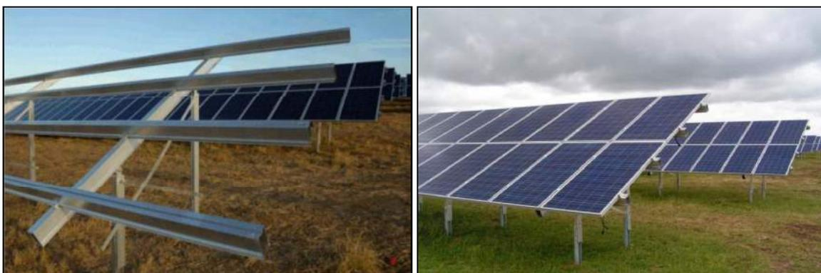
Abbildung 3: Systemdarstellung zur Aufständierung der Gestelleinheiten auf gerammten Pfosten und Detailansicht zweireihiger Modultische. Quelle: S.I.G. 2012.
