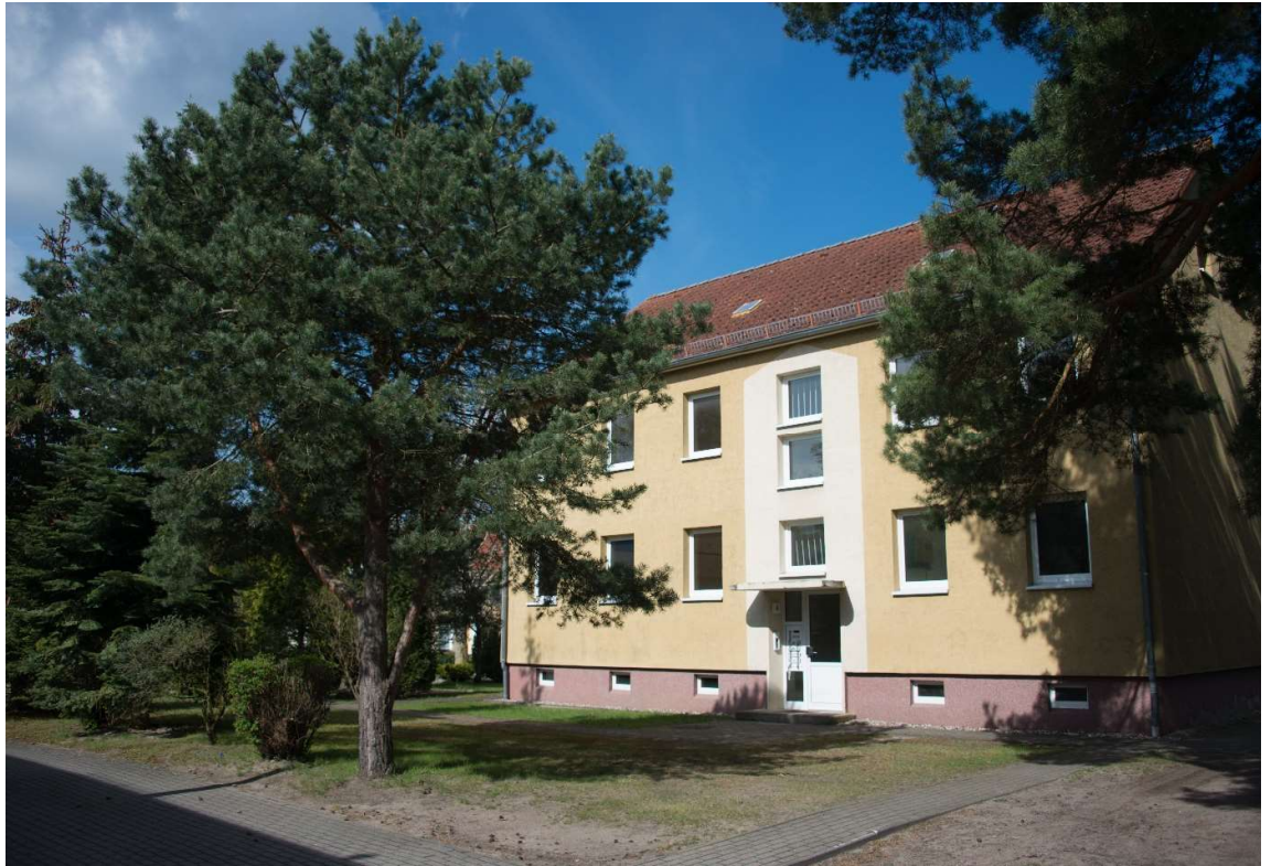
Abb. 1 Blick auf das zum Abriss vorgesehene Mehrfamilienhaus
