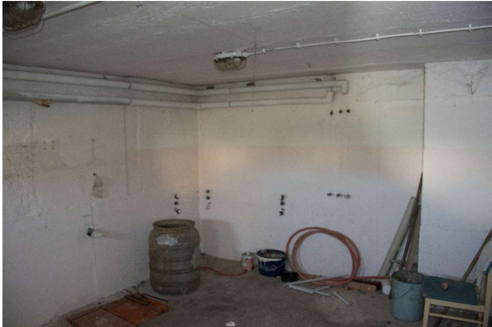
Abb. 4 Situation im Keller des Gebäudes
