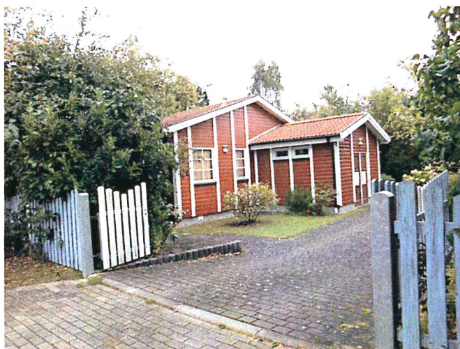
Abb. 6 Auffahrt Waldstraße 11 von der Leuchtturmstraße aus
