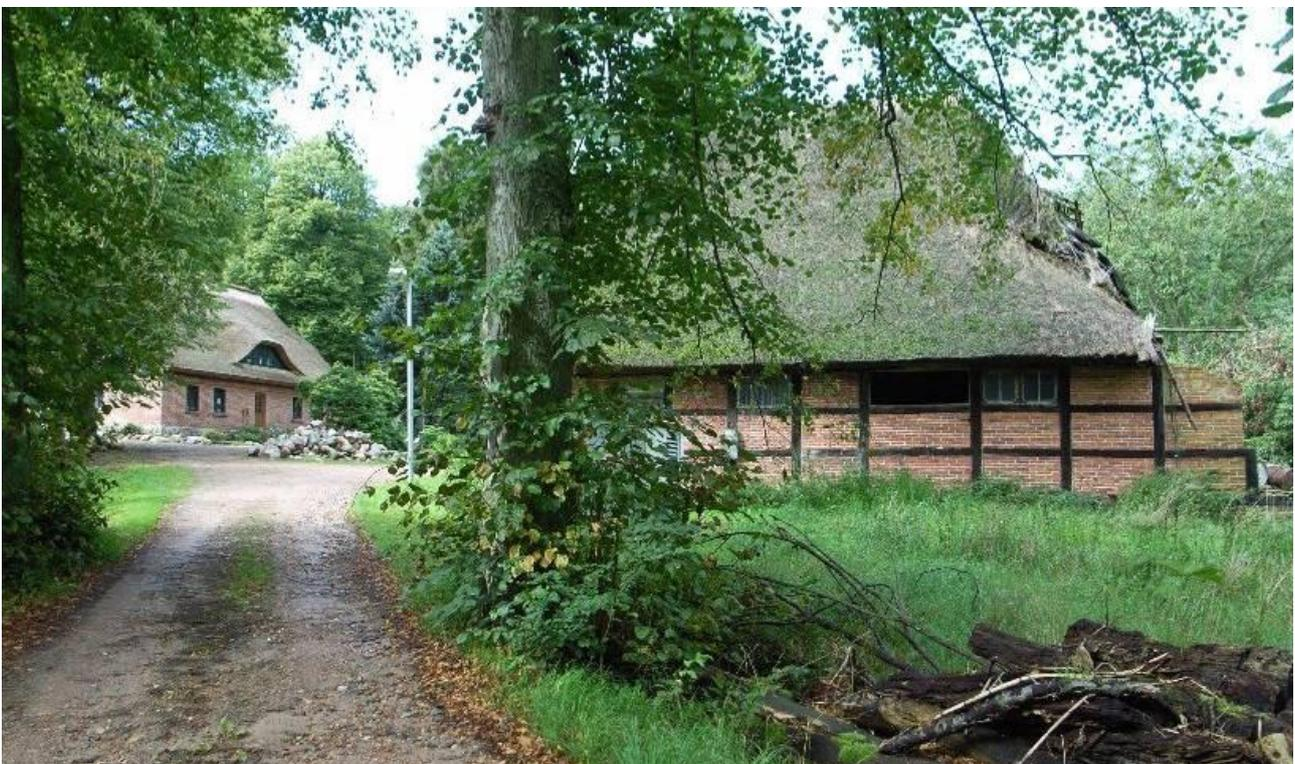
Die Scheune, ein Backstein/Fachwerkbau mit Rohrdacheindeckung war in ihren ursprünglichen Abmessungen ca. 15 m breit und ca. 40 m lang, bei einer Firsthöhe von ca. 11 m. Zum heutigen Zeitpunkt ist nur noch etwa ein Drittel des Gebäudes (Südwestgiebel) erhalten und gesichert. Aufgrund des zwischenzeitlich zu geringen Umfangs des Erhaltungszustandes wurde die Scheune in 2009 (Untere Denkmalschutzbehörde LK Rügen 23.02.2009) aus der Denkmalliste gelöscht.
