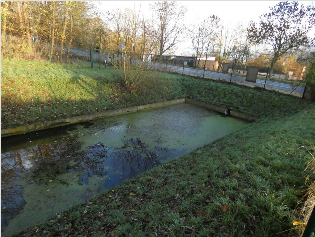
Abbildung 5: Ansicht des vorhandenen Regenwasserbeckens.
