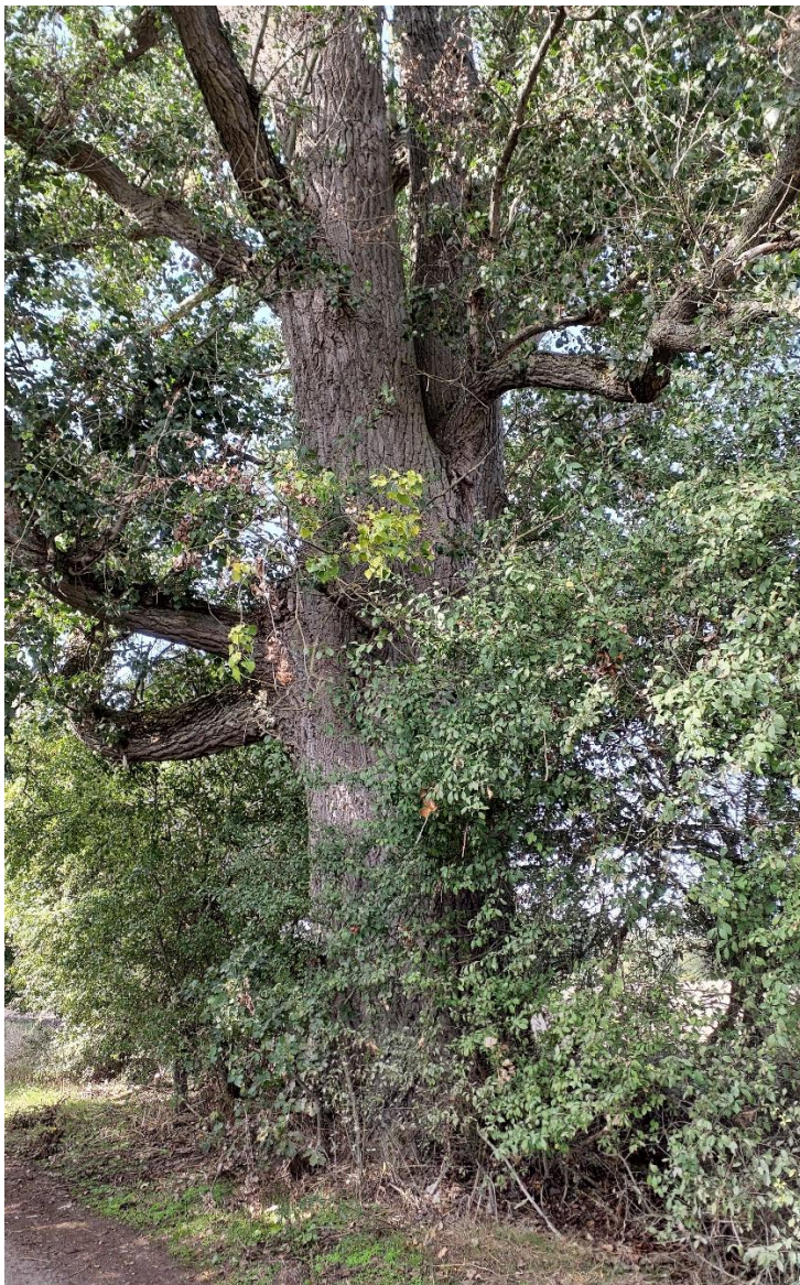
Abbildung 3-8: lückige Allee bei KD_029 im Eingriffsbereich
