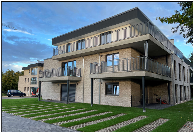
Abb. 3 Inzwischen fertiggestellte Bebauung Haus Nr. 4 (vorne) und Haus Nr. 5 (im Hintergrund) mit Abweichung von den bisher festgesetzten Farbtönen für das Ziegelmauerwerk
