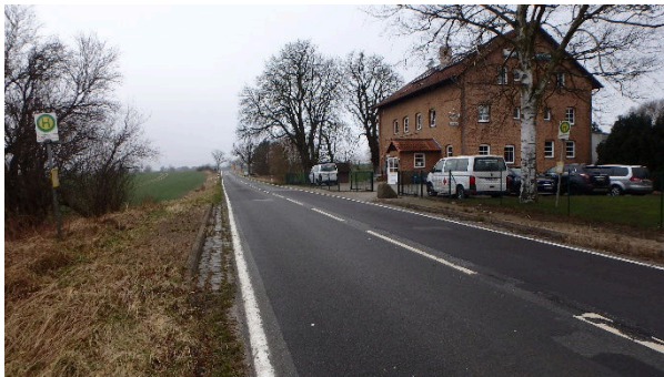
Foto 1: L10 und Hauptgebäude
