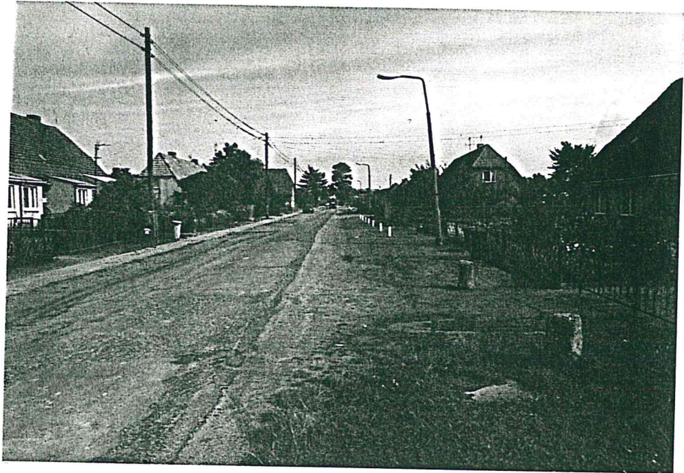
Abb. 7 Ehemalige Gutskaten in der Seebergstraße
