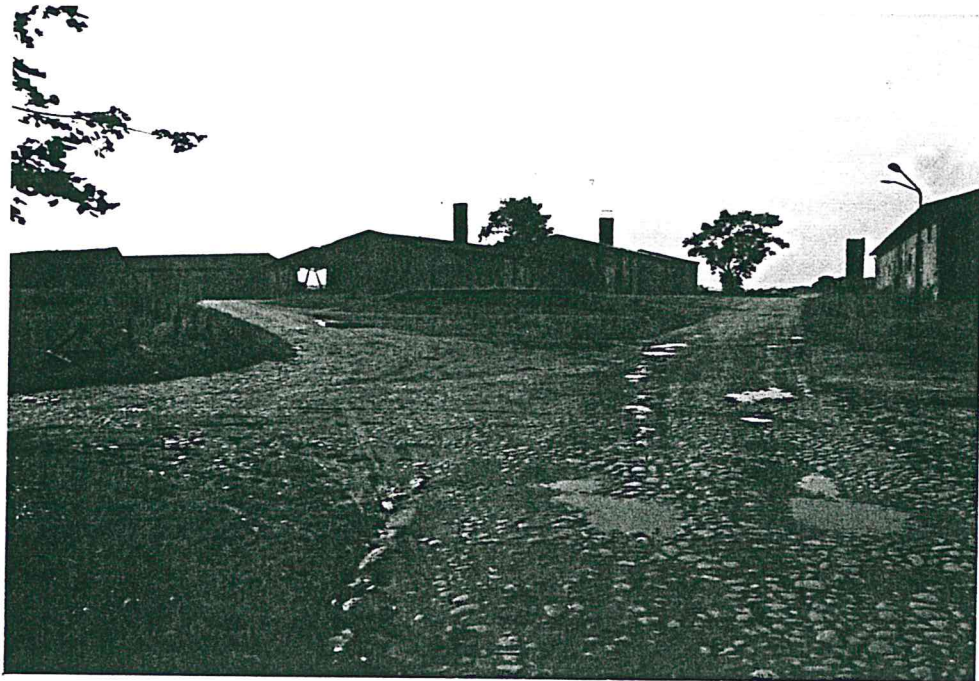
Abb. 5 Wirtschaftsgebäude zum Teil ungenutzt
