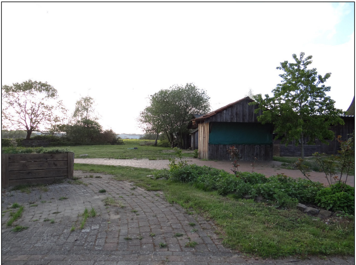
Abb. 6: Backhaus mit Holzverschalung, Foto: P. Blei, 07.05.2019
