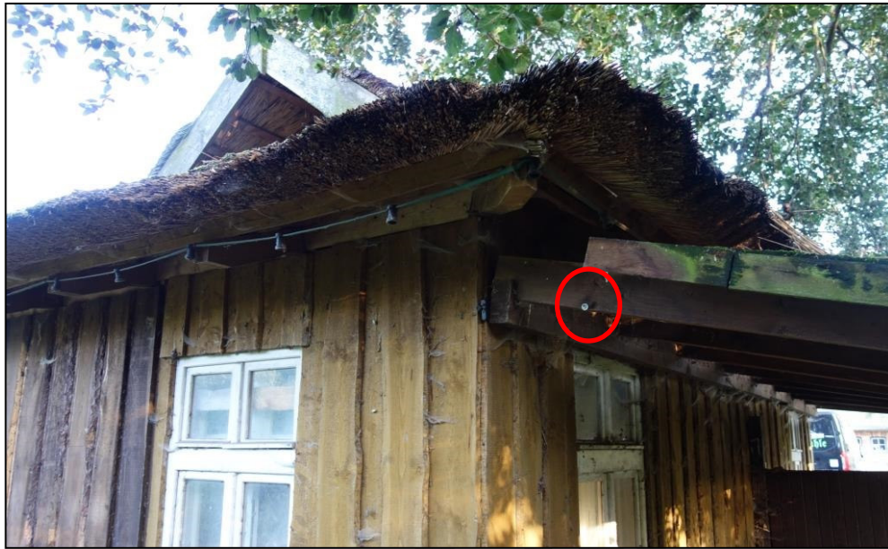
Abbildung 8: Beispiel der Horchboxinstallation (Standort Nr. 6), Foto: P. Blei, 08.08.2019.
