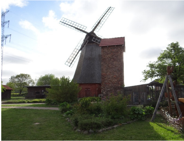
Abbildung 15: Mühle und Trafohäuschen, 12.05.2019
