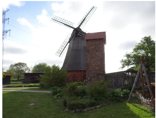
Abbildung 6: Historische Mühle und Nebengebäude, 13.06.2019
