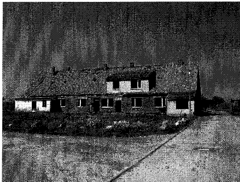
Bild 1: Derzeitige Bebauung innerhalb des Plangebietes, ruinöser Zustand
