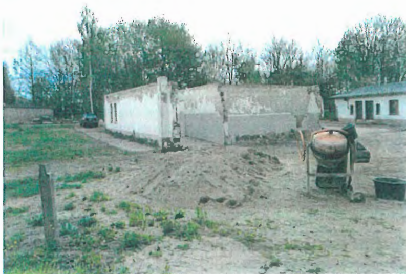
Foto 1: Rückbau der ehemaligen Bäckerei
