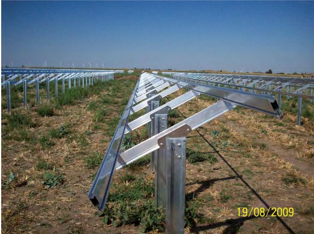
Abbildung 1: Systemdarstellung zur Aufständigung der Gestelleinheiten (ohne Module)
