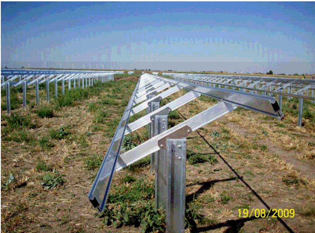
Abbildung 4: Systemdarstellung zur Aufständering der Gestelleinheiten. Quelle: S.I.G. 2011.
