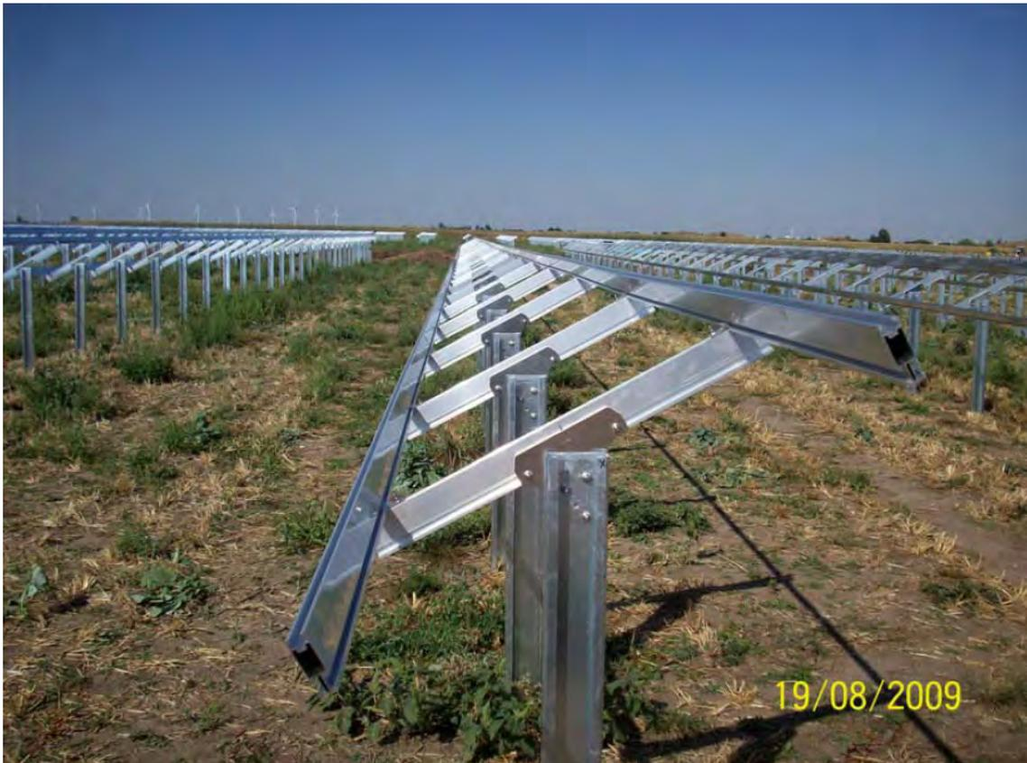
Abbildung 4: Systemdarstellung zur Aufständerung der Gestelleinheiten. Quelle: S.I.G. 2011.
