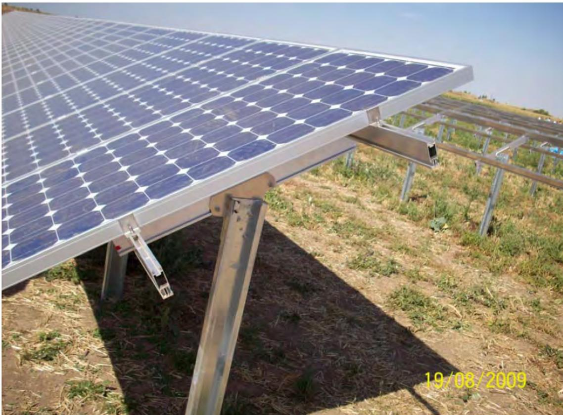
Abbildung 5: Detailansicht der Modultische. Quelle: S.I.G. 2011.
