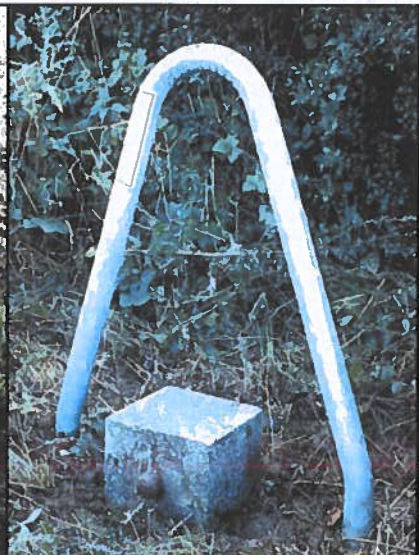
HFP Granitpfiler 25 cm x 25 cm mit seitlichem Bolzen und Stahlschutzbügel
