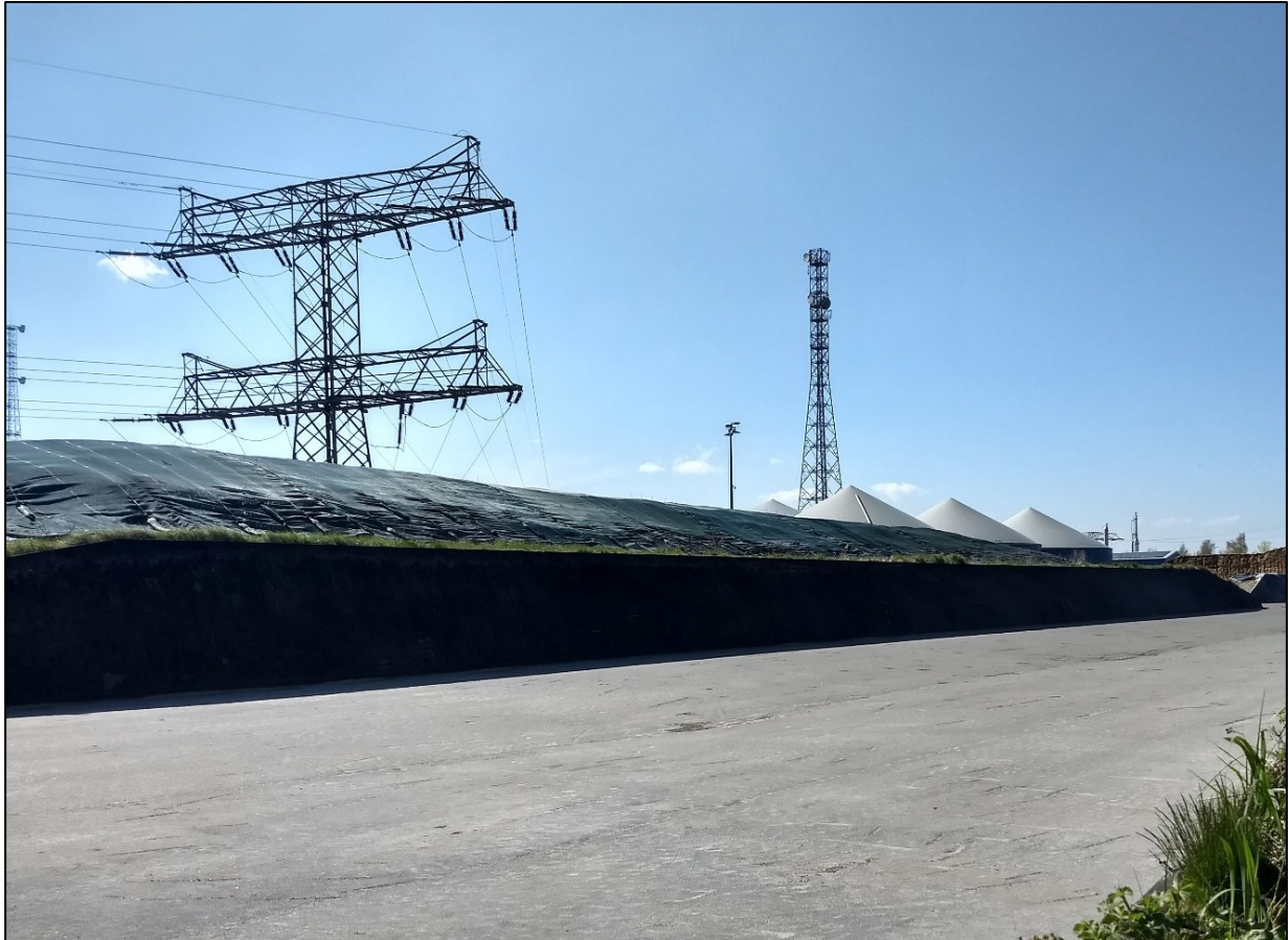
Abbildung 13 Teil der Biogasanlage, im Hintergrund Strom- und Sendemasten
