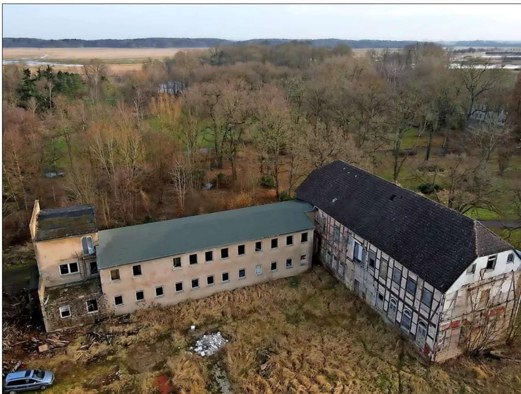
Abb. 27: Rückansicht des alten Kurhauses, bereits abgerissen der Anbau an der Südfassade (Quelle: www.ostsee-zeitung.de , Bad Sülze: Altes Kurhausgelände wird Baustelle, vom 24.04.2021, Quelle Foto: Marcel Kapschefsky)
