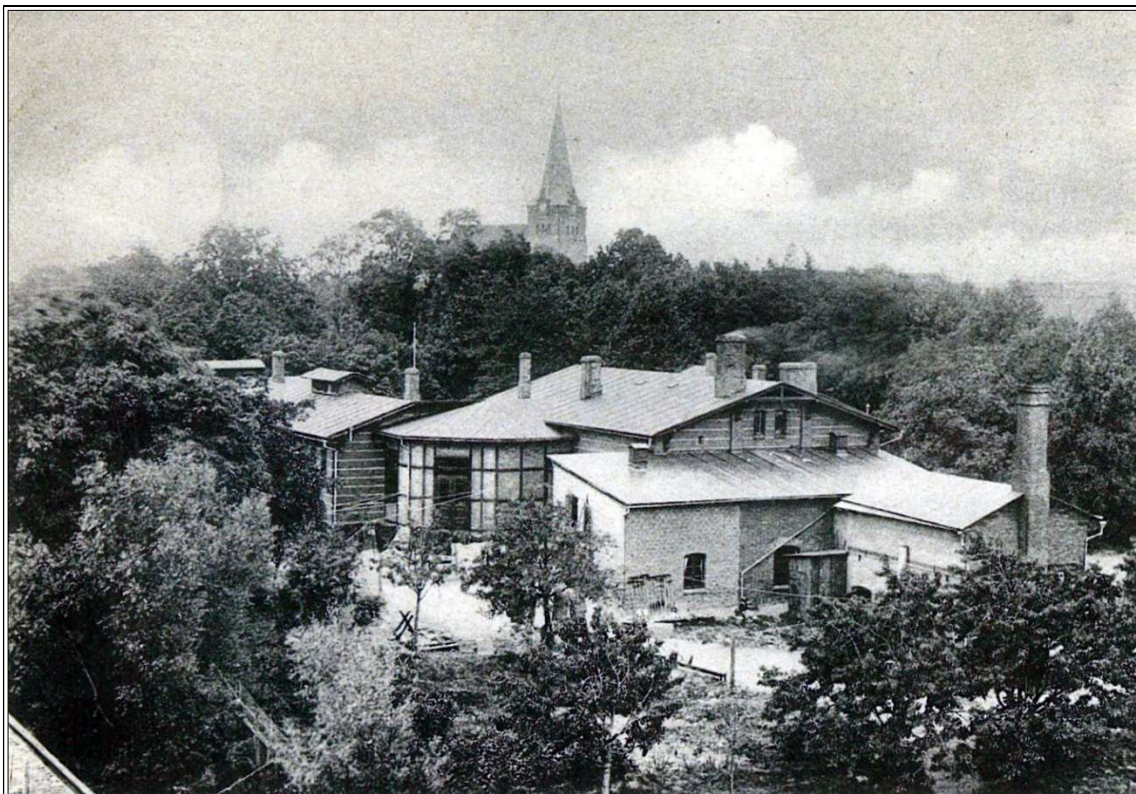
Abb. 24: Die Rückseite von Haus Bethesda, Blick vom „Friedrichsbau“ auf die Anlage, um 1900 (Quelle: Wulfert, S. 88)
