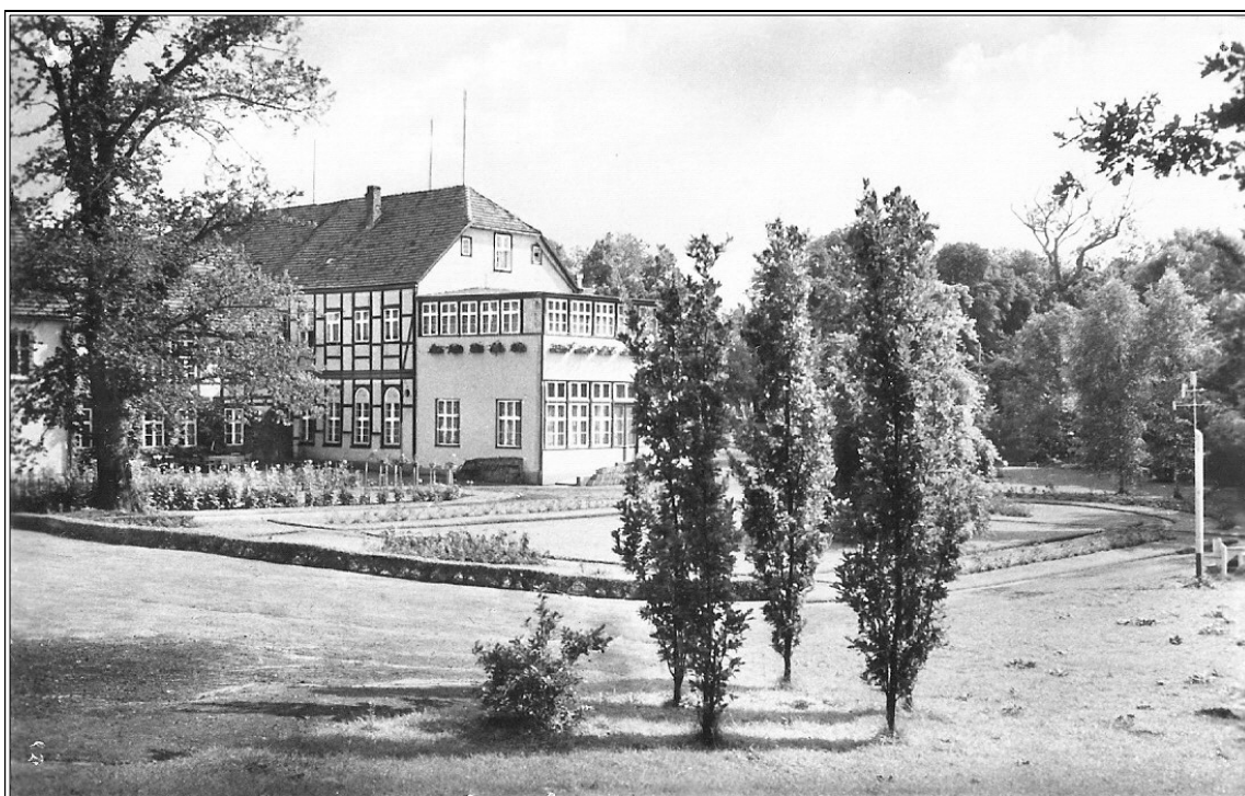
Abb. 21: Blick über den Rosengarten auf das Sanatorium mit dem neu verputzten Anbau (Speisesaal), um 1960 (Quelle: Salzmuseum Bad Sülze)
