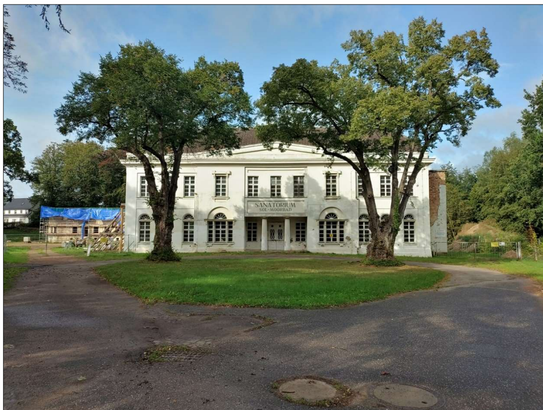
Abb. 32: Zufahrt zum Alten Kurhaus, Rondell mit zwei alten Lindenbäumen, Blick nach Westen, links im Hintergrund ohne Dachstuhl der Neubau von 1929 (04.10.2023)
