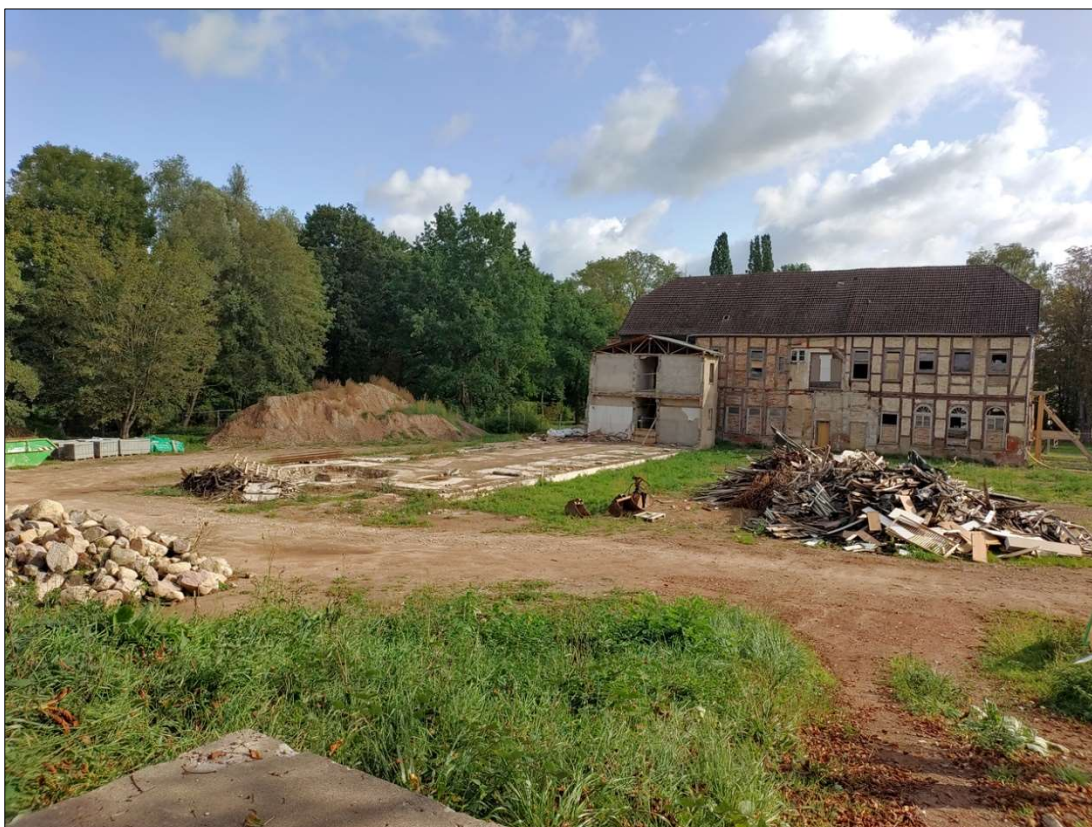
Abb. 41: Blick vom Plateau nach Osten auf die Rückseite Altes Kurhaus, abgerissen sind der Flügel nach Westen und der Anbau an der Südseite (04.10.2023)
