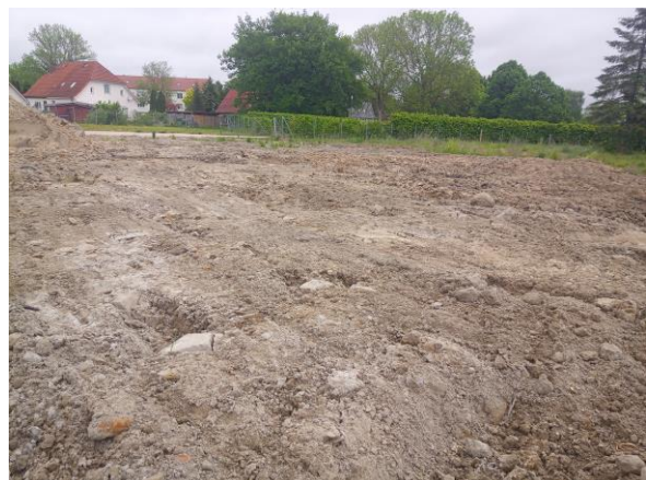
Abb.7: Blick auf das Untersuchungsgebiet (Rückbaubereich) am 24.05.23
