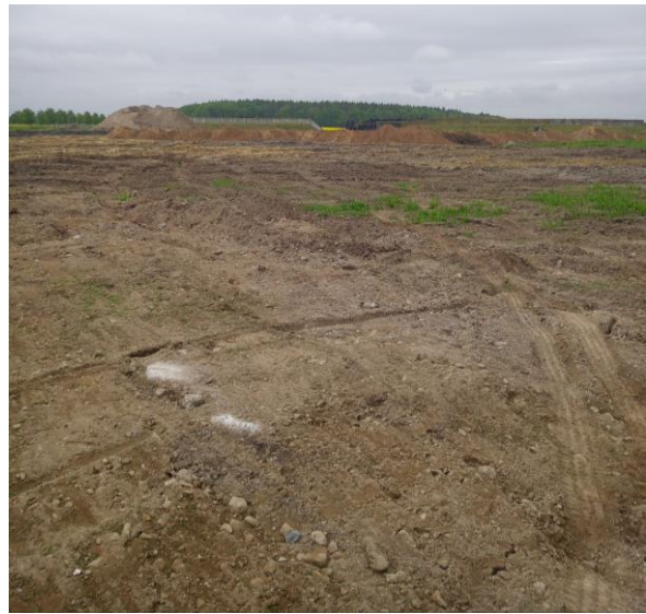
Abb.6: Blick auf das Untersuchungsgebiet (Rückbaubereich) am 24.05.23
