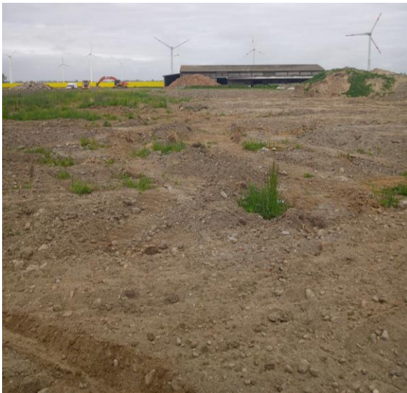
Abb.5: Blick auf das Untersuchungsgebiet (Rückbaubereich) am 24.05.23
