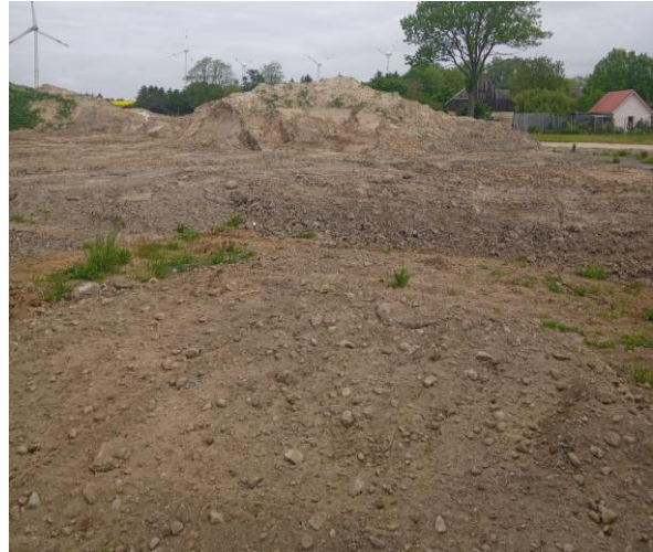
Abb.4: Blick auf das Untersuchungsgebiet (Rückbaubereich) am 24.05.23
