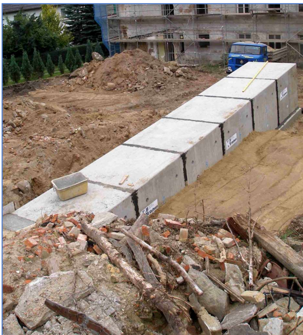
Abb. 18 bis 20 Tunnelartiger Anbau an einen Fledermauskeller zur Ver- legung des Einfluges im Zuge einer Überbauung.
