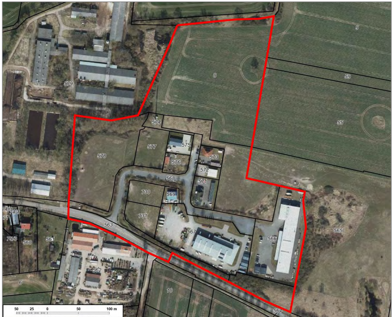
Abb. 1: Untersuchungsgebiet innerhalb des Plangebietes zum B-Plan Nr. 5 „Gewerbegebiet Stralendorf“, Quelle Luftbild: https://www.geoportal-mv.de/gaia/gaia.php .
