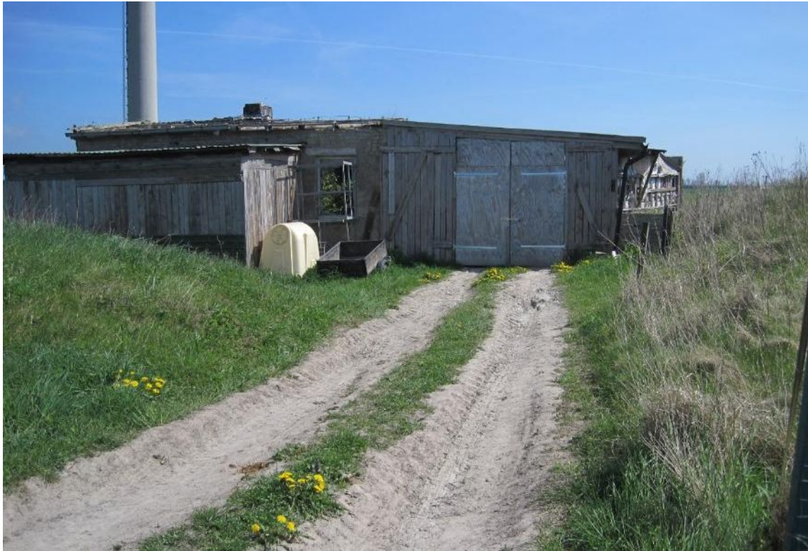
Abbildung 34: Holzschuppen an der westlichen und südlichen Seite des gemauerten Gebäudes
