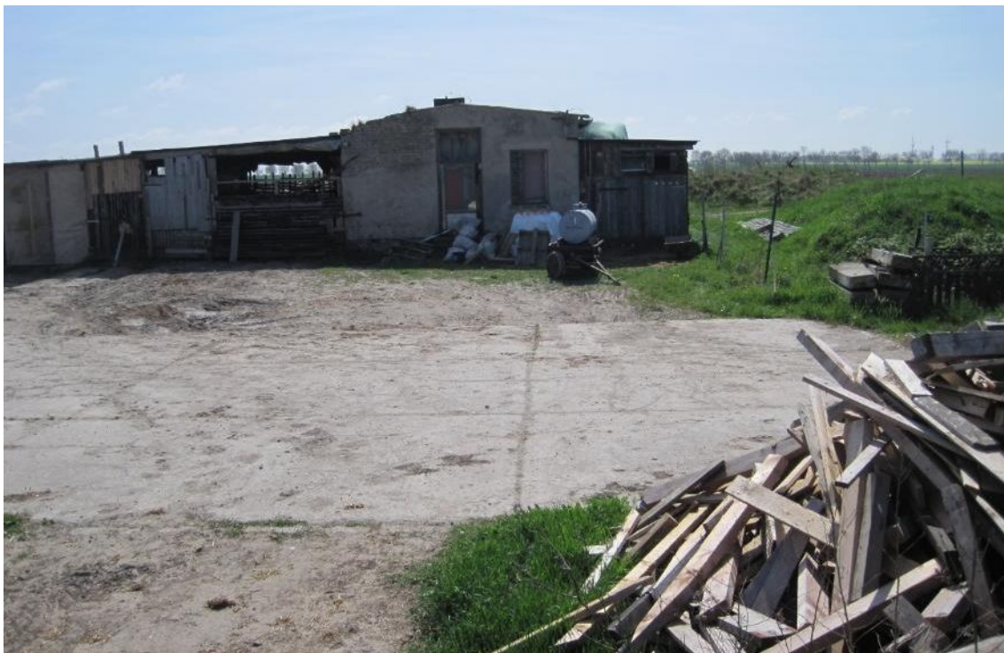
Abbildung 33: Gebäudebestand landwirtschaftliche Betriebsanlage
