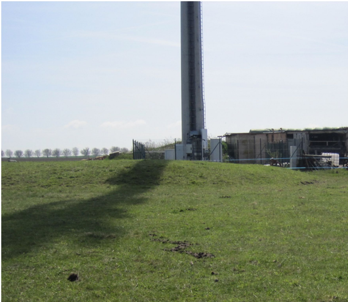
Abbildung 36: Bereich des Funkturmes (außerhalb des PGs), im Hintergrund Bodenmiete und landwirtschaftliche Gebäude
