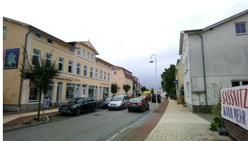
Abb. 43: Hauptstraße mit hohem Pkw-Aufkommen
